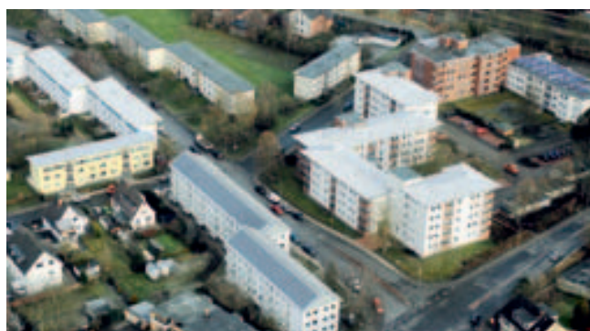
Die Siedlung Wulsdorf am Kreuzungsbereich Ringstr./Thunstr.
